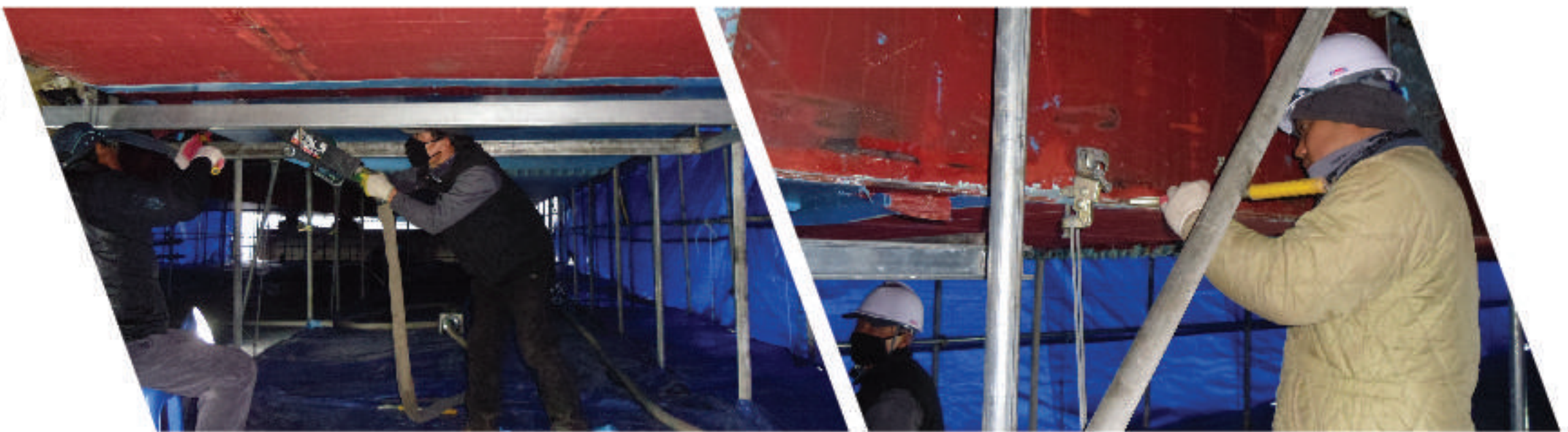
죽산교 보수공사 (순천국토관리사무소)
